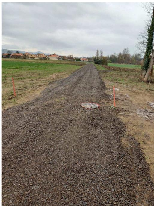
Mise à la côte des tampons dans l'impasse terminée. La pose des acodraïns, les grilles transversales et grille avaloir est terminée. La mise en œuvre de déchet de carrière sur le chemin est réalisé.
